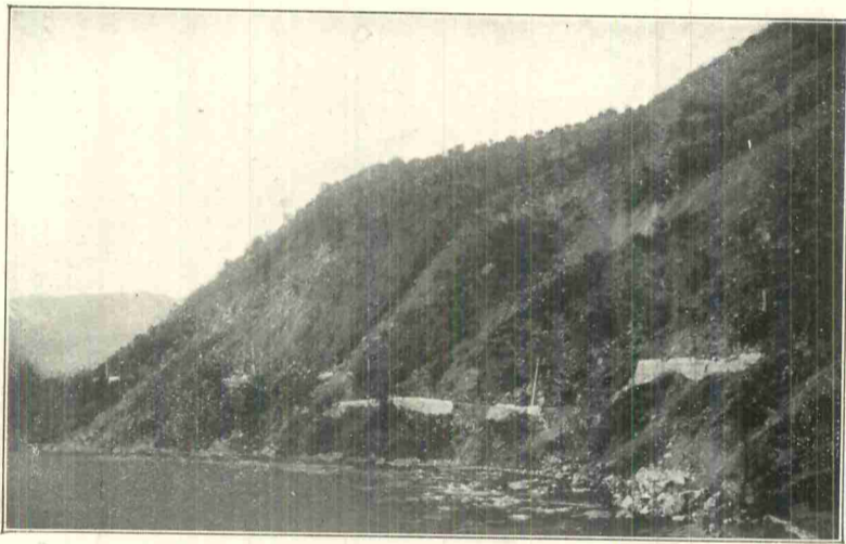
Fig. 8 Tronçon de route entraîné à Marquixanes
